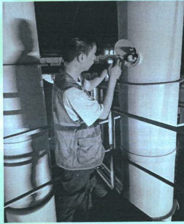
废气处理后采样口 DA003
