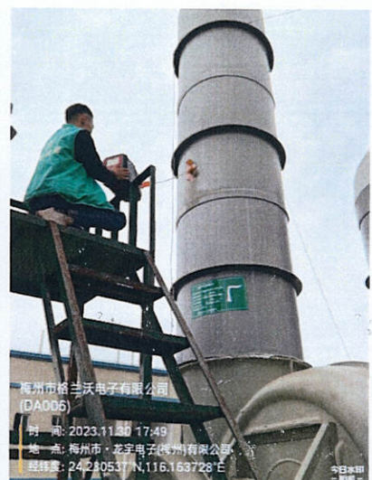
有机废气排放口 DA006
